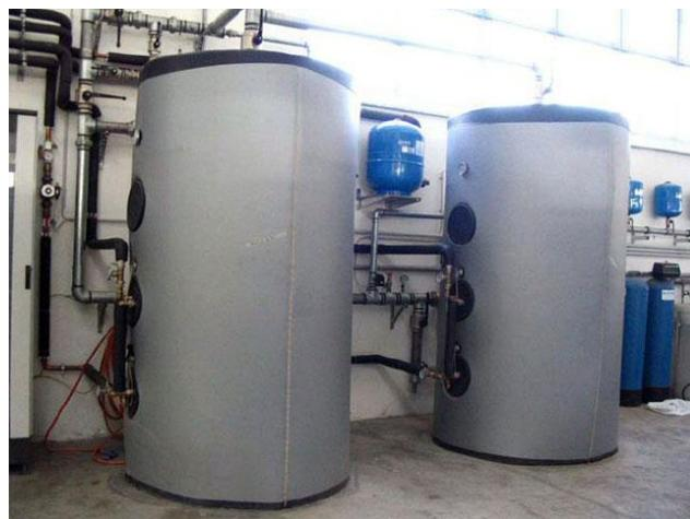
Immagine R.3.1 Fonte dati Solarge. Impianto solare termico su sito produttivo agroalimentare a Gallo (Fe)
