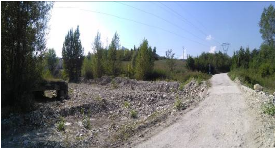
VSITA LATERALE ALVEO, GUADO ESISTENTE E PILE VECCHIO PONTE
