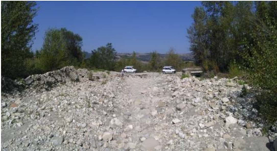
VISTA DA MONTE ALVEO IN GHIAIA E CIOTTOLI
