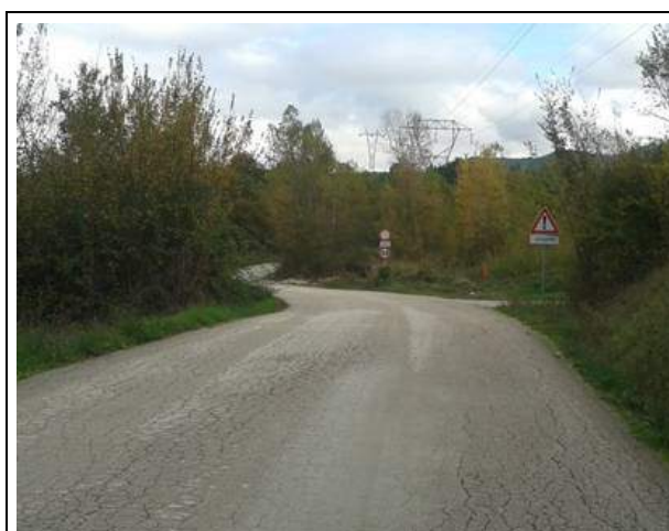
Accesso al cantiere da via Boscara
